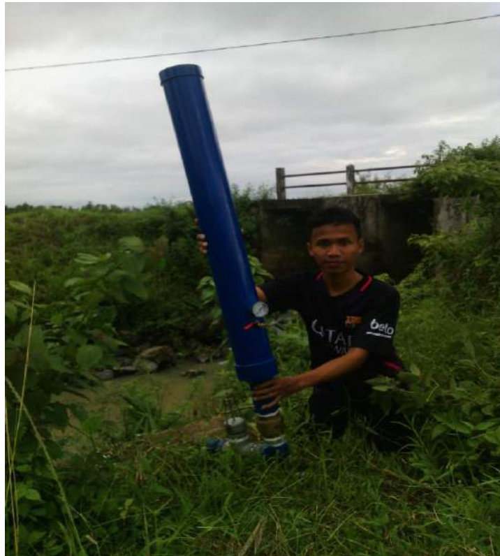
Gambar 4.4. Tempat Pemasangan Pompa Hidram di Desa Sidoasri
