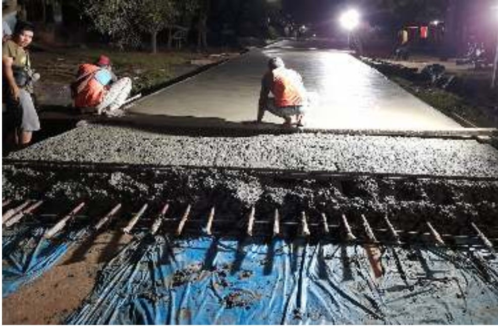
Proses Perataan Adukan Beton
