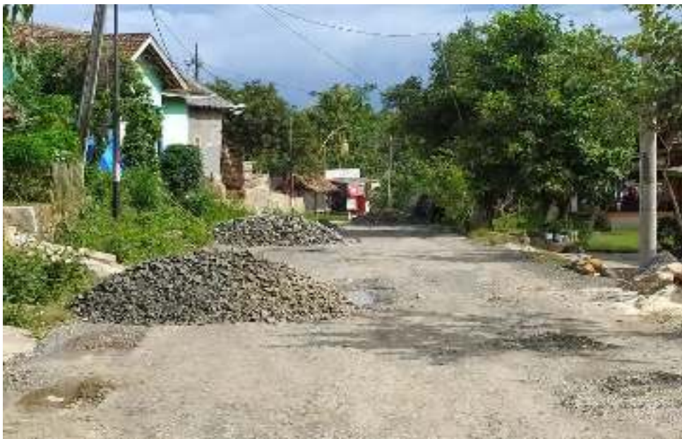
Penempatan Matreial Pada Titik Nol ( STA 0+000)
