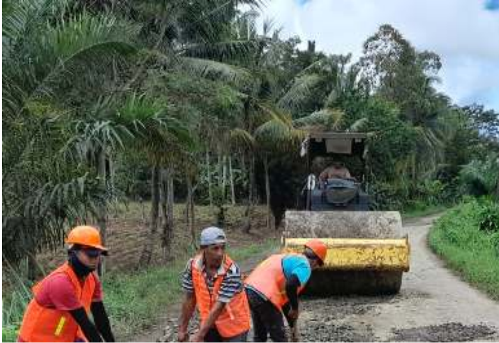
Proses Pematatan Jalan
