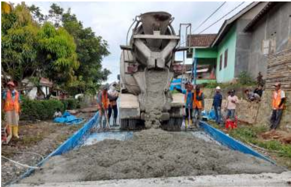
Proses Penuangan Adukan Beton
