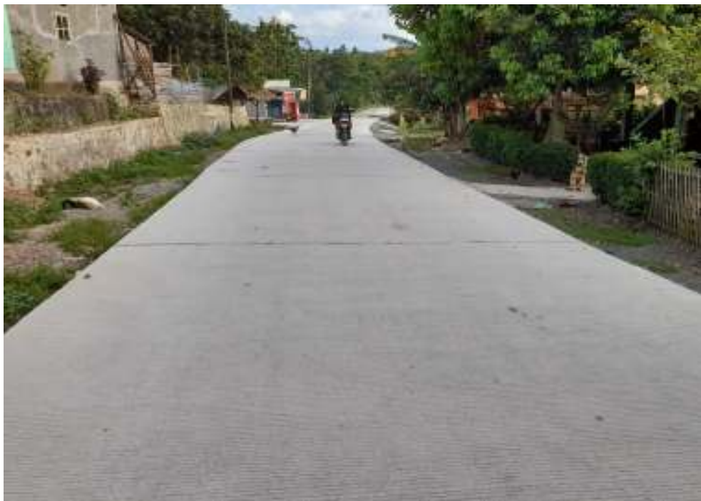
Kondisi Jalan Setelah Di Perbaiki
