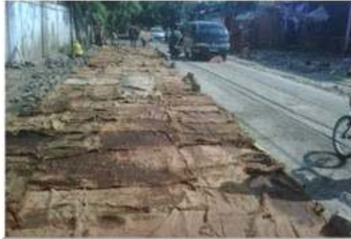
Gambar 3.2 Perawatan beton dengan karung goni
