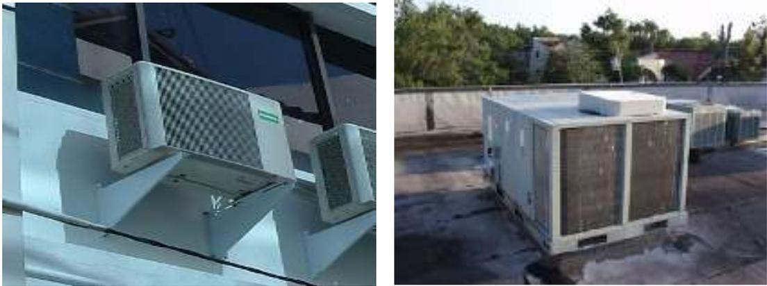
Gambar.1.4 Kondensor yang diletakan di luar ruangan (out door)
