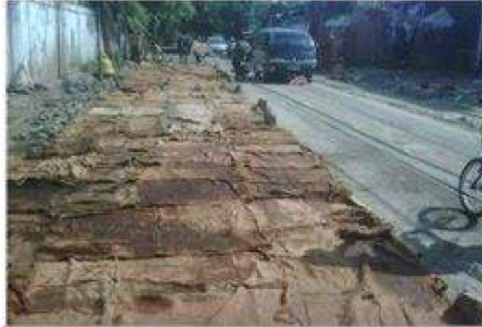
**Gambar 3.2 Perawatan beton dengan karung goni**
