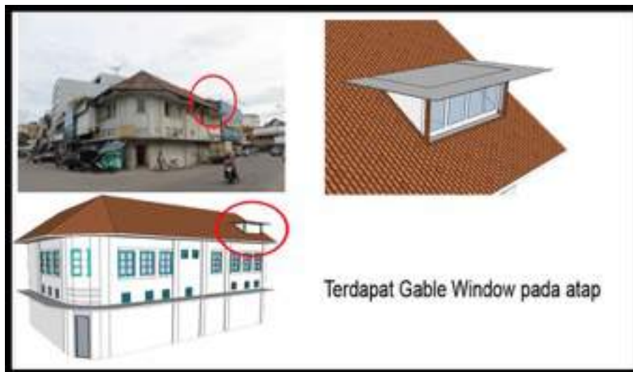
Gambar 5.13. Gable Window pada atap Sumber : Dokumentasi Pribadi
