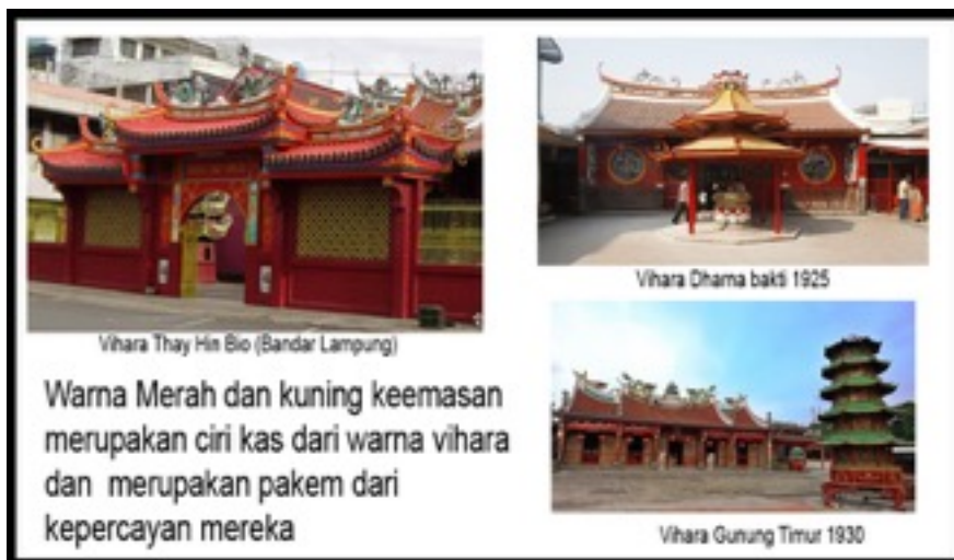
Gambar 5.11. Warna Bangunan Sumber : Dokumentasi Pribadi
