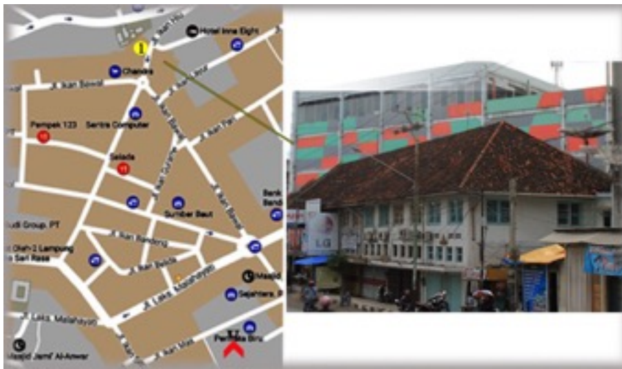
Gambar 5.1. Bangunan di Jl. Ikan Hiu Sumber : Dokumentasi Pribadi
