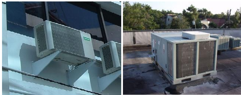
Gambar 2.10. Jenis Kondensor Terpasang
