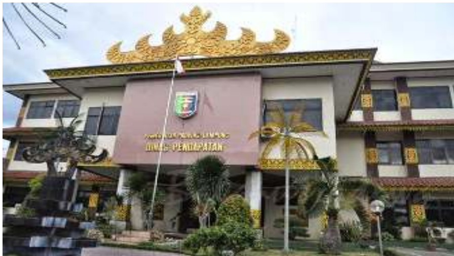
Gambar 1.2. Kantor Dinas Pendapatan Provinsi Lampung
