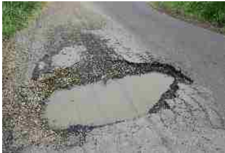
Gambar. 2.3. Kerusakan Potholes
